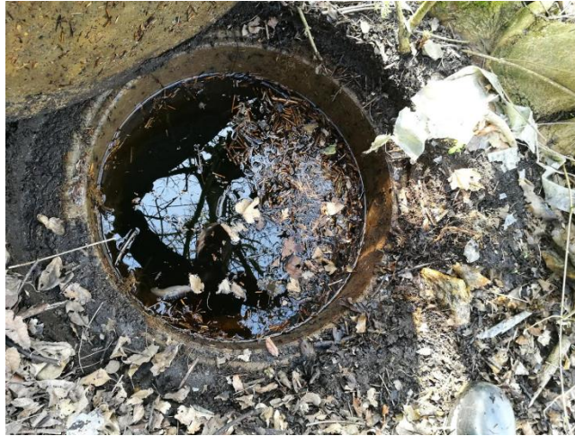
Figur 1. Tilstoppet brønd.
