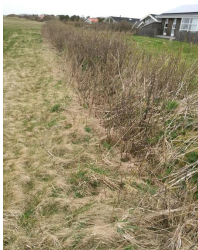
Figur 5. Dårligt vedligeholdt grøft.
