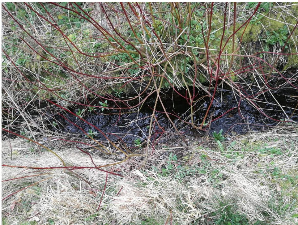
Figur 3. Grøft med vand i terræn.
