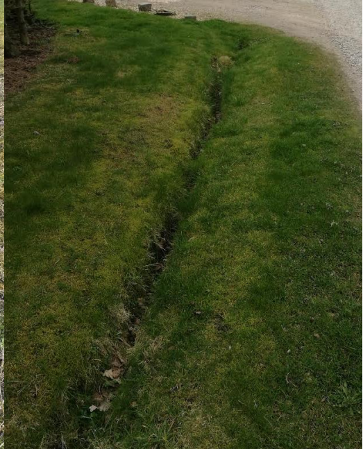
Figur 6. Grøft med et meget bredt tværsnit.
